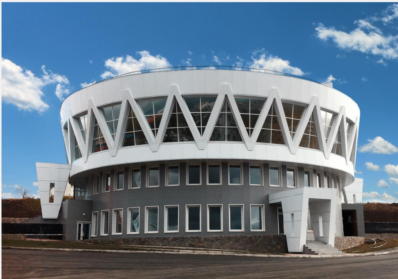
→ Дворец бракосочетаний Петропавловск-Камчатский, проспект Циолковского, 52 Материал: КраспанКомпозит-ST, керамогранитные плиты Подсистема: U-BCт Краспан Площадь фасада: 1500 кв.м 2014
