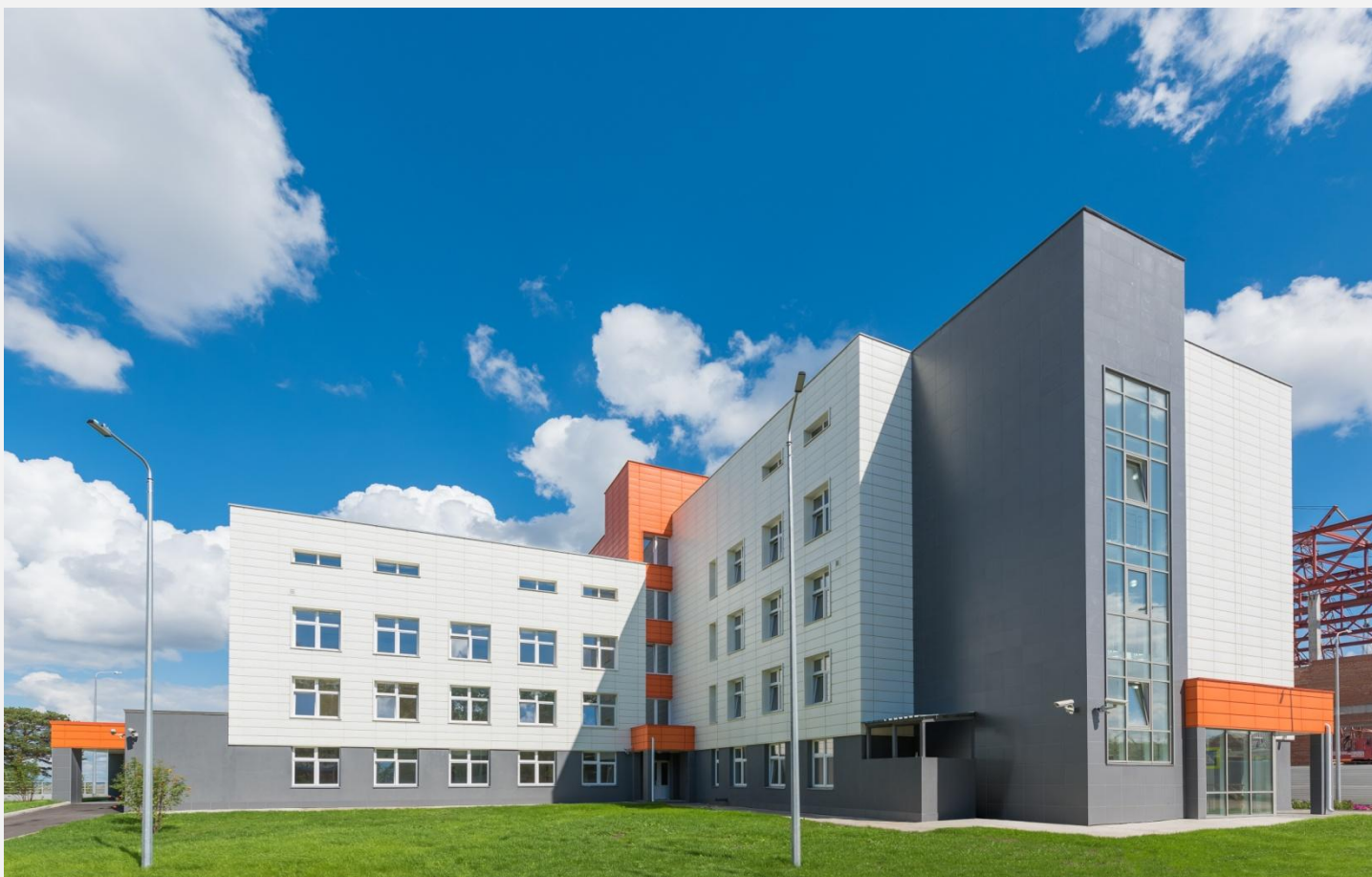
➔ Медицинский центр Красноярск, деревня Универсиады Материал: КраспанМеталлТекс Подсистема: U-BCт Краспан Площадь фасада: 2648 кв.м 2017
