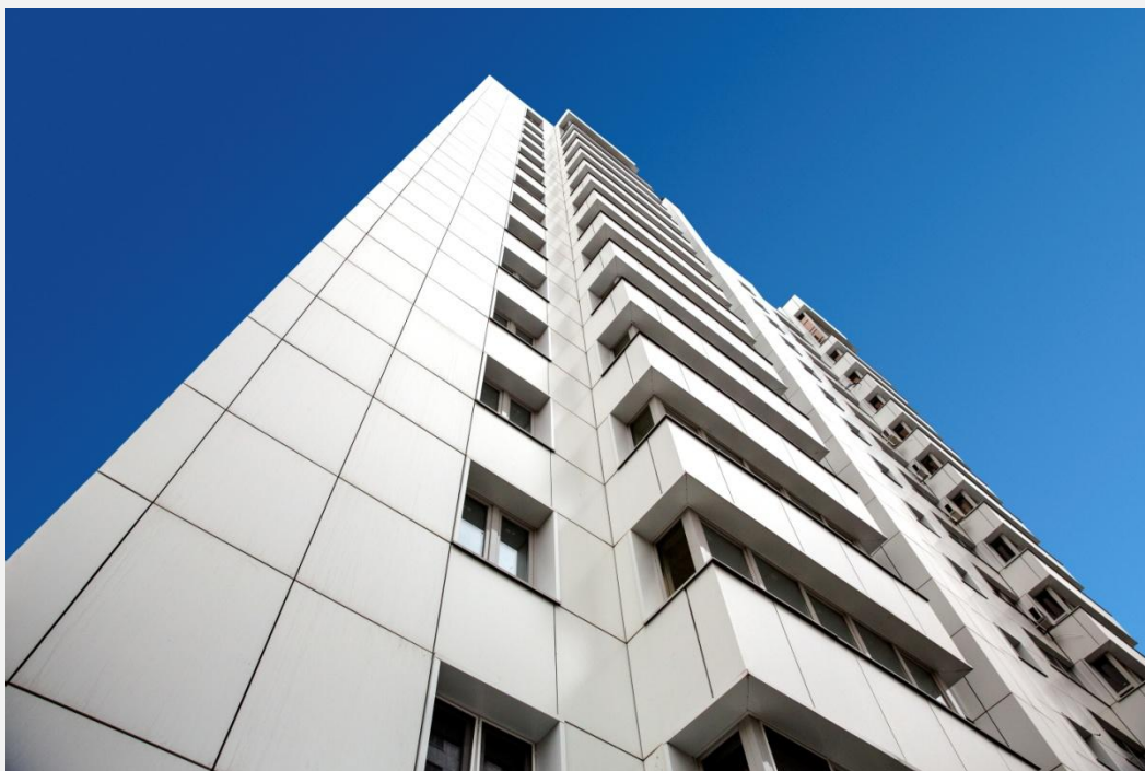
→ Жилой комплекс «Отражение» Абакан, пр-т Дружбы народов, 43 Материал: КраспанКомпозит-СТ, КраспанМеталлКолор Подсистема: U-BCт Краспан Площадь фасада: 3110 кв.м 2016
